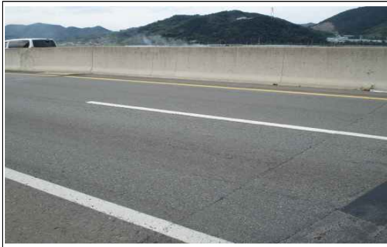
교면포장 상행선 S1 라벨링
