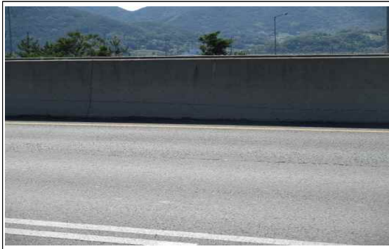
교면포장 상행선 S2 라벨링
